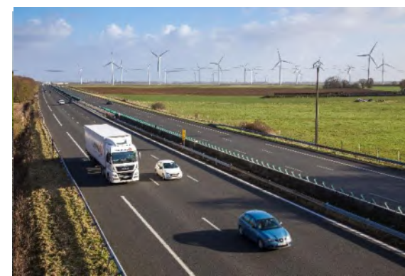
Photo 18. L'autoroute A1 à Tilloloy et le parc visible au sud de Roye
