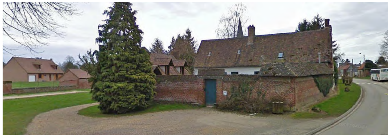
Photographie 9. L'intersection entre la rue d'Etelfay et la rue du Sac à Lignières
