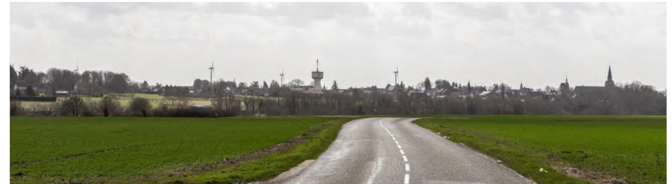
Photo 37. Entrée nord via la RD41 et la silhouette de Montdidier
